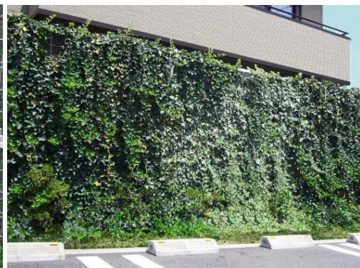
施工後2年5ヶ月
