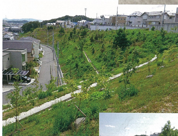
宅地造成のり面 植穴掘削が困難な造成のり面に張り付け。新興住宅地に雑木林を復元(兵庫県)
