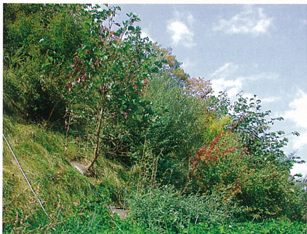
植穴掘削が困難な軟岩切土のり面への苗木植栽 早期自然復元を目指し、多様な樹種を使用 施工後2年でH=4m程度に生長(岐阜県)
