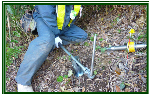
↑ 引抜き作業状況
