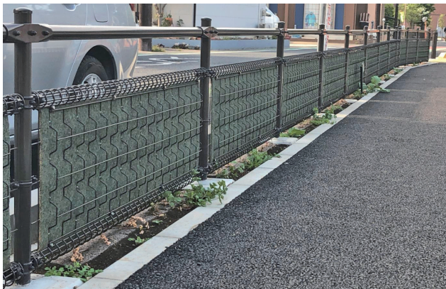
埼玉県さいたま市 (施工直後)
