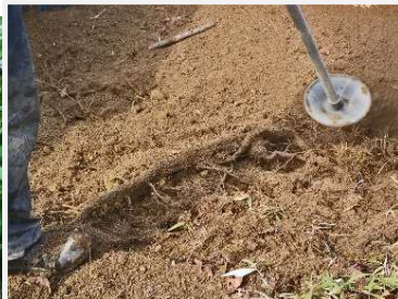
エアーによる土砂掘削
