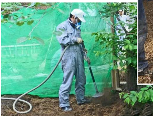
エアーによる土砂掘削
