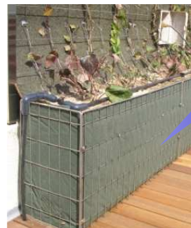
植栽幅が取れない場所に 薄型プランターを設置した事例
