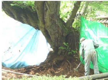
エアースコップを用いて掘削
