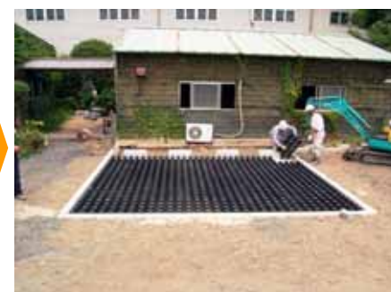
GTPパネル設置
