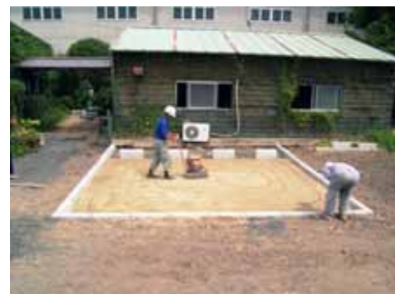
クッション砂敷均し
