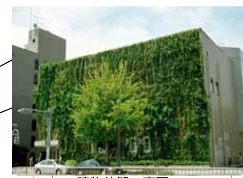
建物外観（東面）
